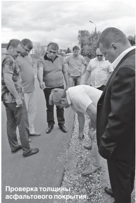
Проверка толщины асфальтового покрытия.
